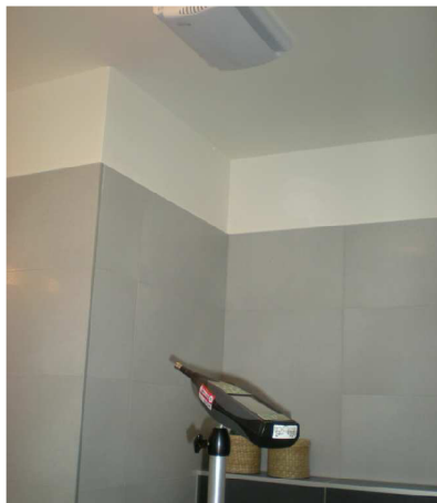
Obr. 3 Ukázka jednoho z měřených prostorů s ventilátorem
