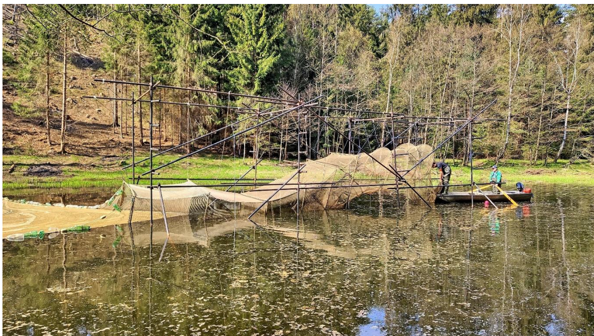
Obr. 2. Vězenec v přítoku nádrže Římov upevněný na větší konstrukci z lešenářských trubek (Foto: https://eu.zonerama.com/fishecu/ ).
