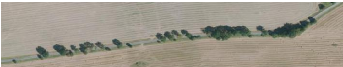
Obr. 83: Fotografie částečně dochované aleje lemující část silnice mezi Chodovou Planou a Kyjovem, na mapě nese označení písmenem a. Výřez letecké mapy dostupné z www.mapy.cz [25.3.2018].
