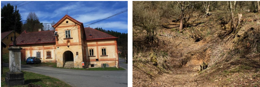
Obr. 16 a 17: Budova Bergamtu a zaniklý důl Michal (Vokrojová, 2018).
