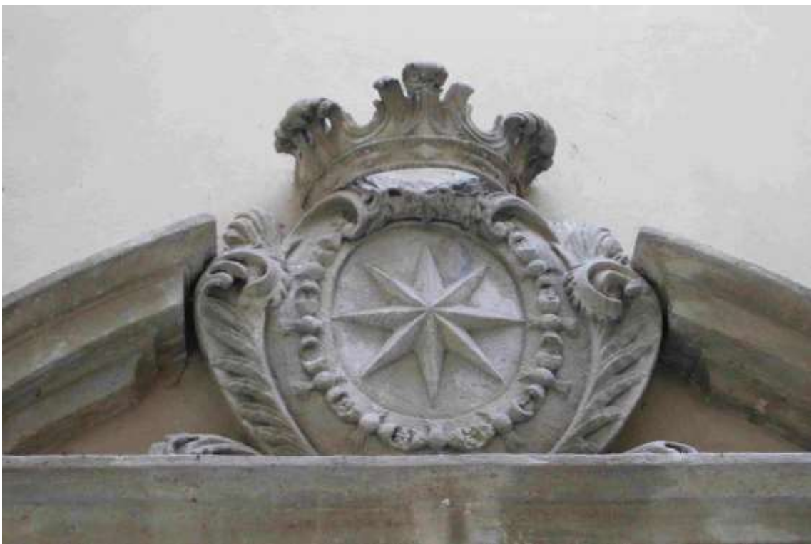
Obrázek 35: Častolovice, zámek, průjezd v severním křídle
