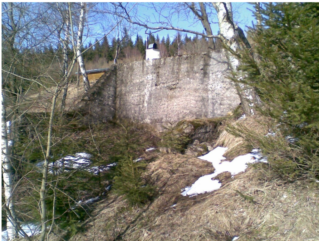
Fotografie 21 – fragmenty budov na Rovnosti
