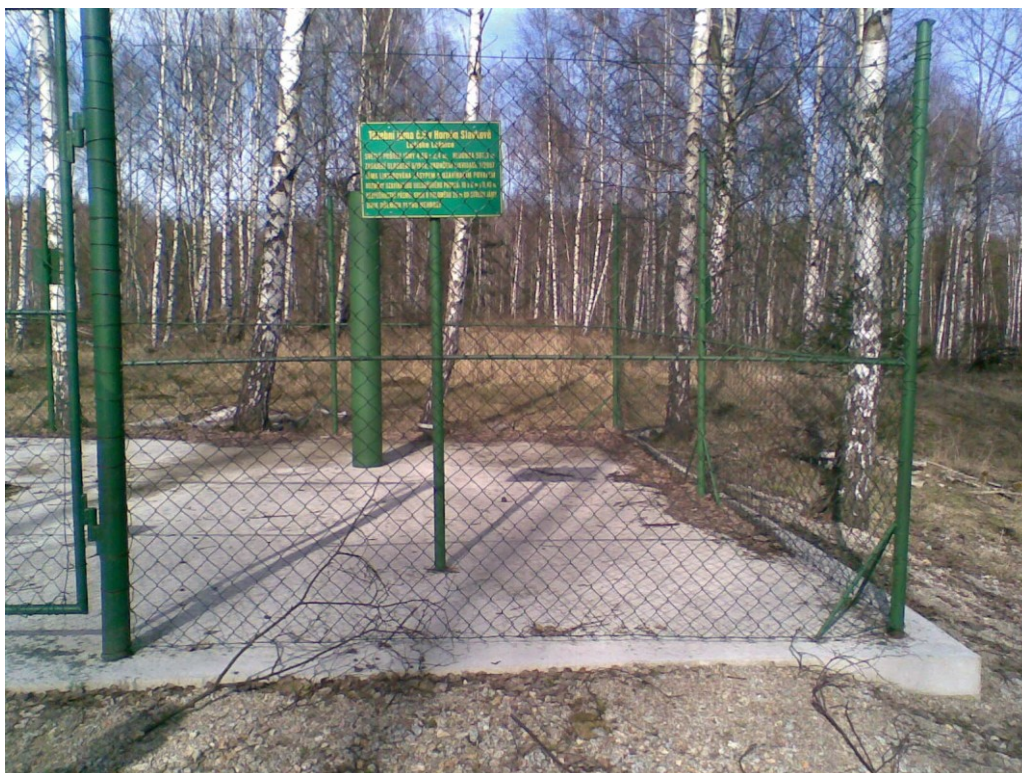
Fotografie 4 – zabezpečená těžní jáma šachty Ležnice, pracoviště politických vězňů
