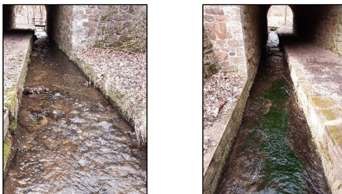
Obr. 26, 27: Úsek č. 7 pod železniční tratí (zdroj: J. Žilová, 2023)
