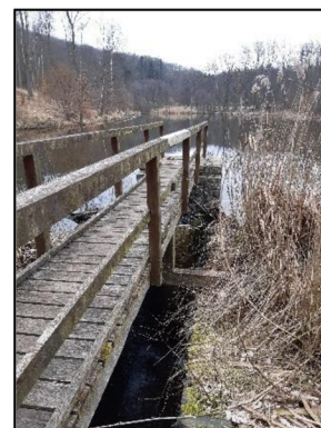
Obr. 57: Přístupová lávka nad požerákem, Opina (zdroj: J. Žilová, 2023)
