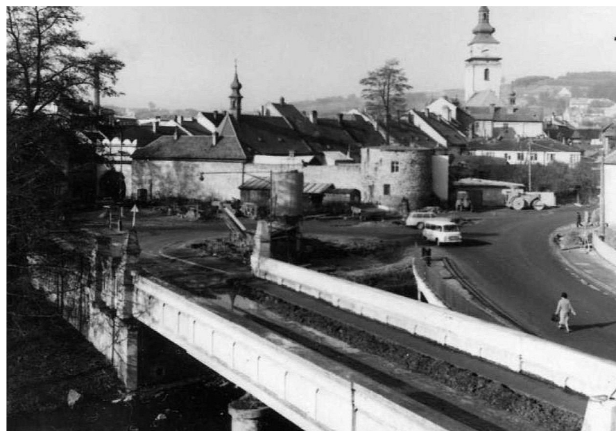
Obr. 43: Historická fotografie ze 60. let minulého století vysvětluje zvláštní tvar jižního cípu poloostrova, navazoval na něj přímo dnes již neexistující most, který byl nahrazen novým (na fotografii vpravo). Dnešní stav poloostrova je tak výsledkem mnoha kompromisů, zejm. ponechání struktur, které již pozbyly svůj původní účel.
