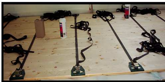
Obr. 4-5 Montáž palubové podlahy (20)
