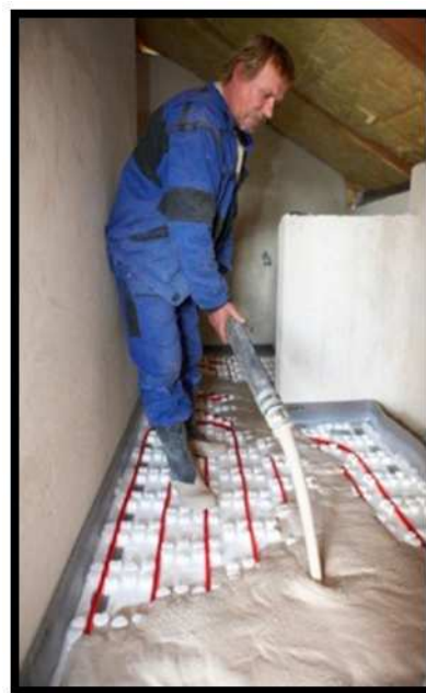
Obr. 6-10 Aplikace anhydritu (41)
