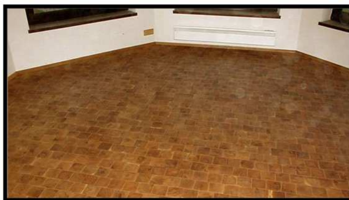
Obr. 33. Špalíková dlažba – interiér (27)
