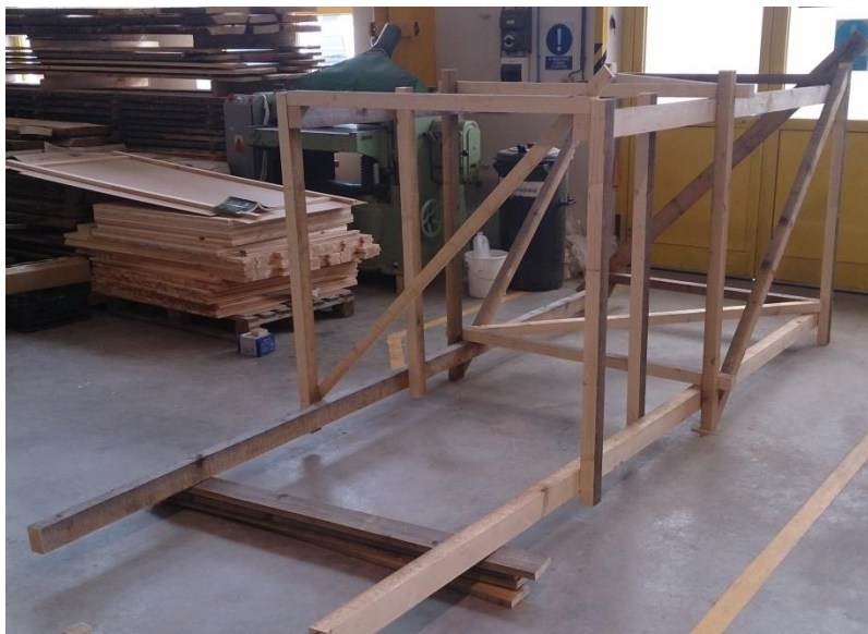
Obrázek 24: Průběh stavby naháňkového posedu (autor)
