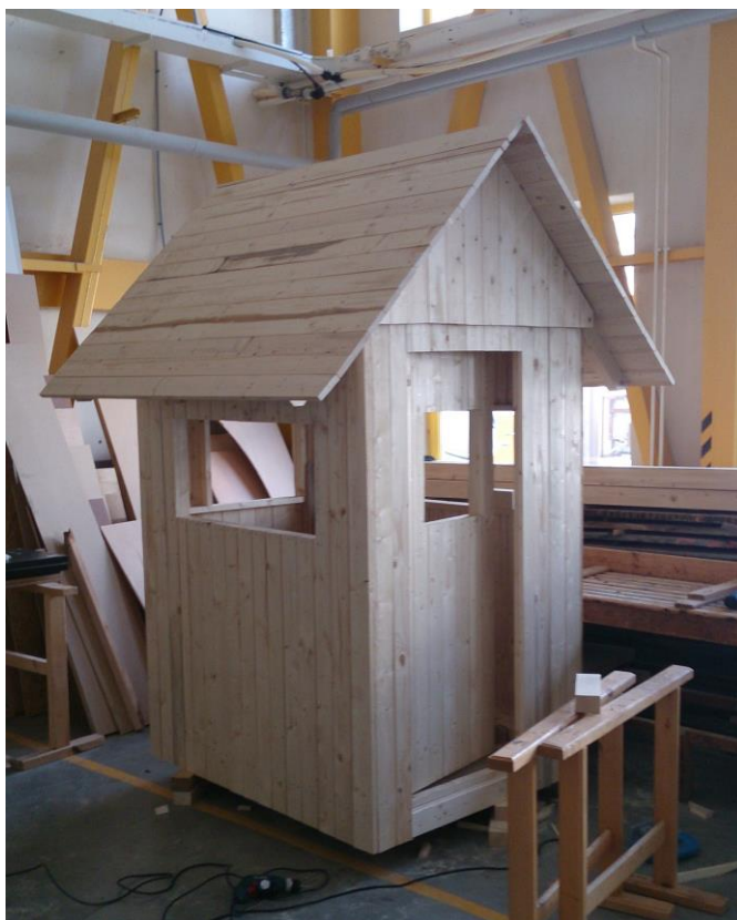
Obrázek 21: Zkompletované opláštění kazatelny před umístěním oken (autor)
