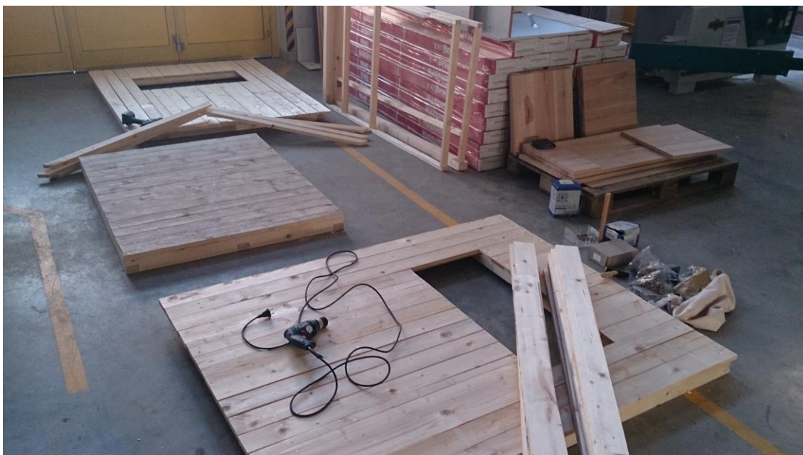
Obrázek 18: Podlaha a delší stěny kazatelny připravené k sestavení (autor)
