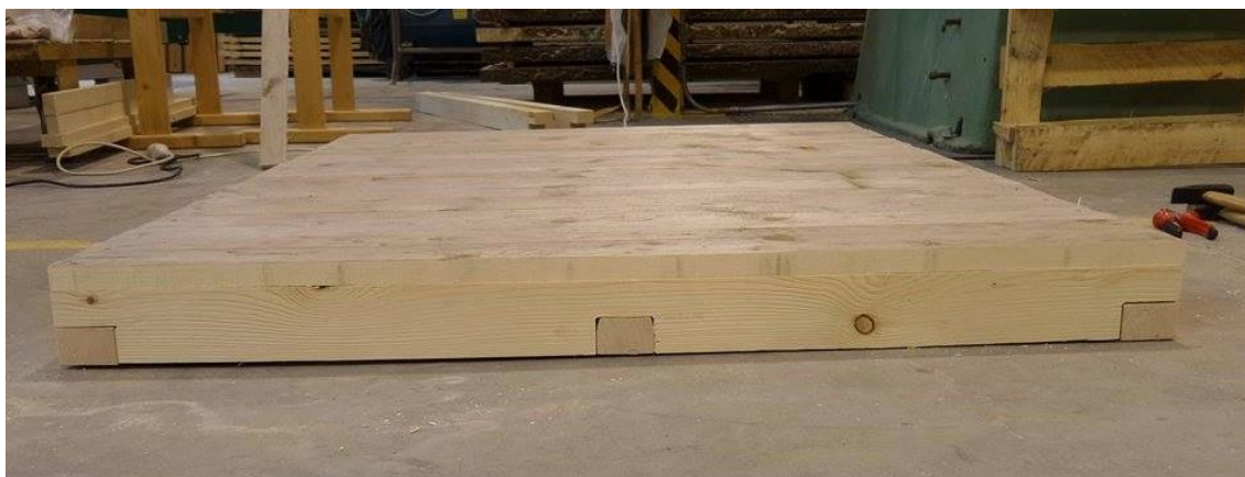
Obrázek 17: Podlaha kazatelny s přeplátováním nosníků
