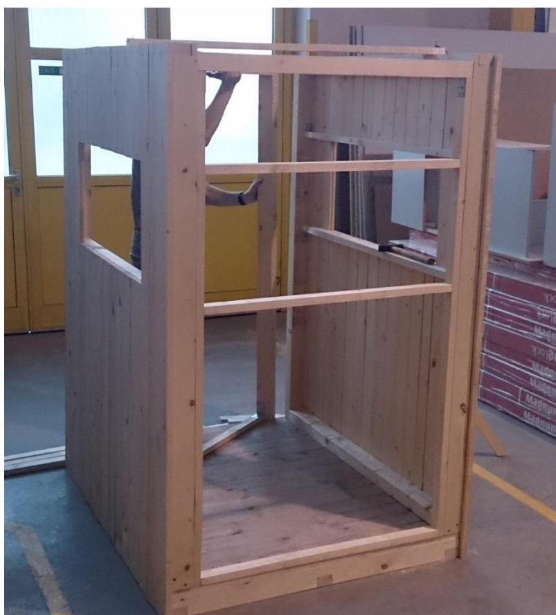
Obrázek 19: Delší stěny kazatelny usazené na podlahu (autor)
