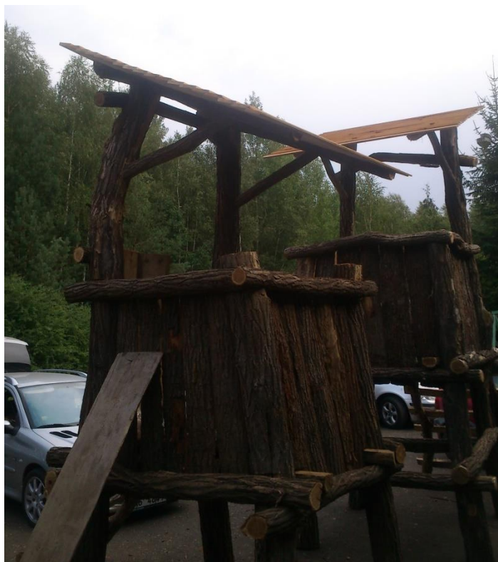
Obrázek 8: Naháňkové posedy vyrobené z akátového dřeva (autor)
