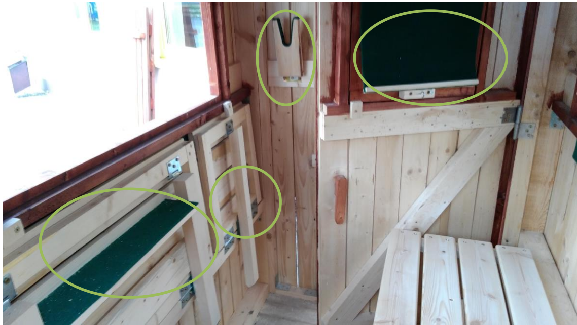
Obrázek 28: Sklopné dělené lavice se sklopnými podpěrami, sklopný držák zbraně, polička pod sedátkem lavice, otočná petlice, zakrytí oken (autor)
