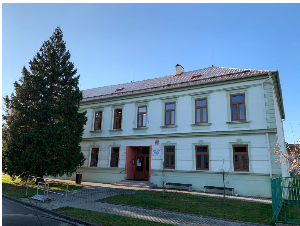
Příloha č. 3: Budova školy na Lipovém náměstí. Zdroj: archiv autora.
