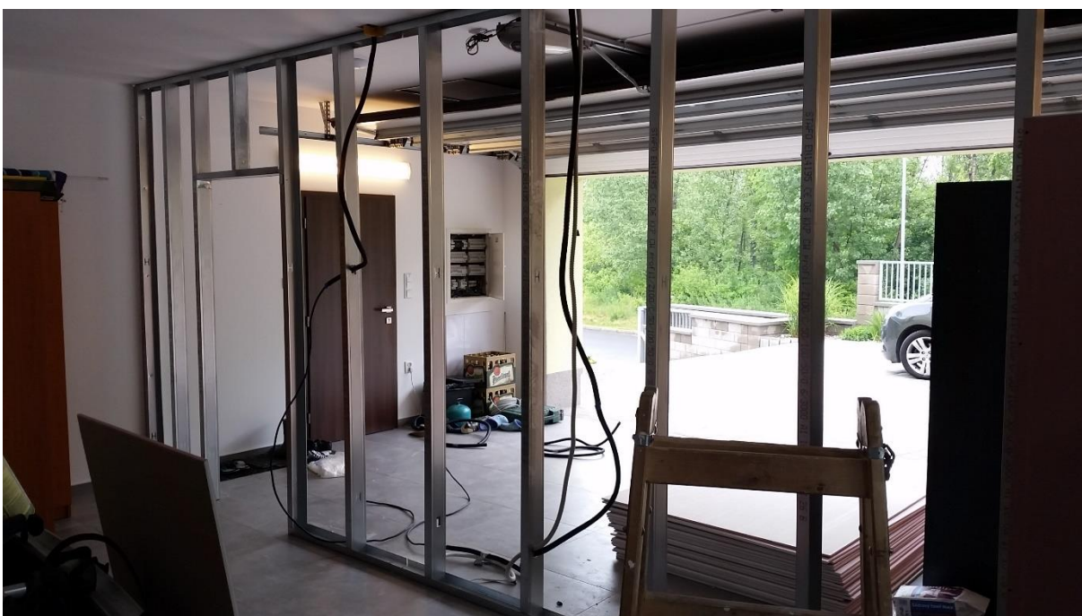
Konstrukce příčky z hliníkových profilů
