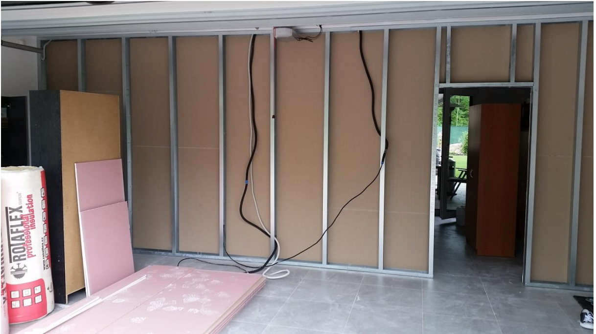
Zaklopený sádrokarton ze sádrokartonových desek z jedné strany
