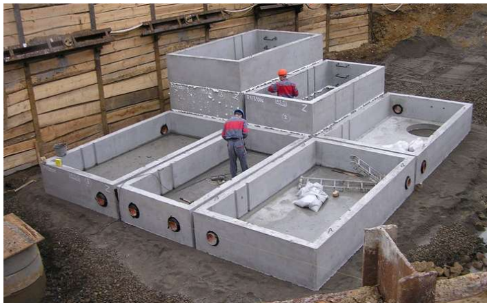
Obr. 5 Montáž kombinované retenční nádrže
