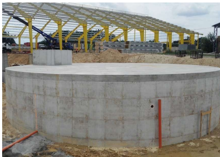
Obr. 4 Monolitická železobetonová uzavřená retenční nádrž
