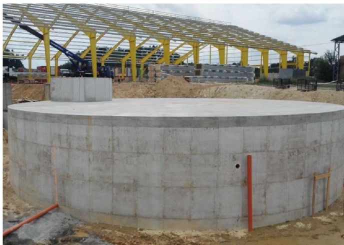
Obr. 4 Monolitická železobetonová uzavřená retenční nádrž
