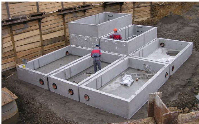
Obr. 5 Montáž kombinované retenční nádrže
