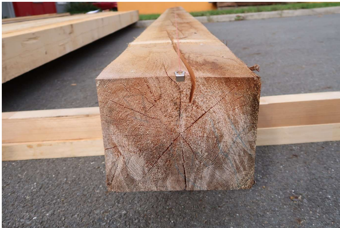
Obrázek 4.14 – přichycení lajnovací šňůry označující osu trámu
