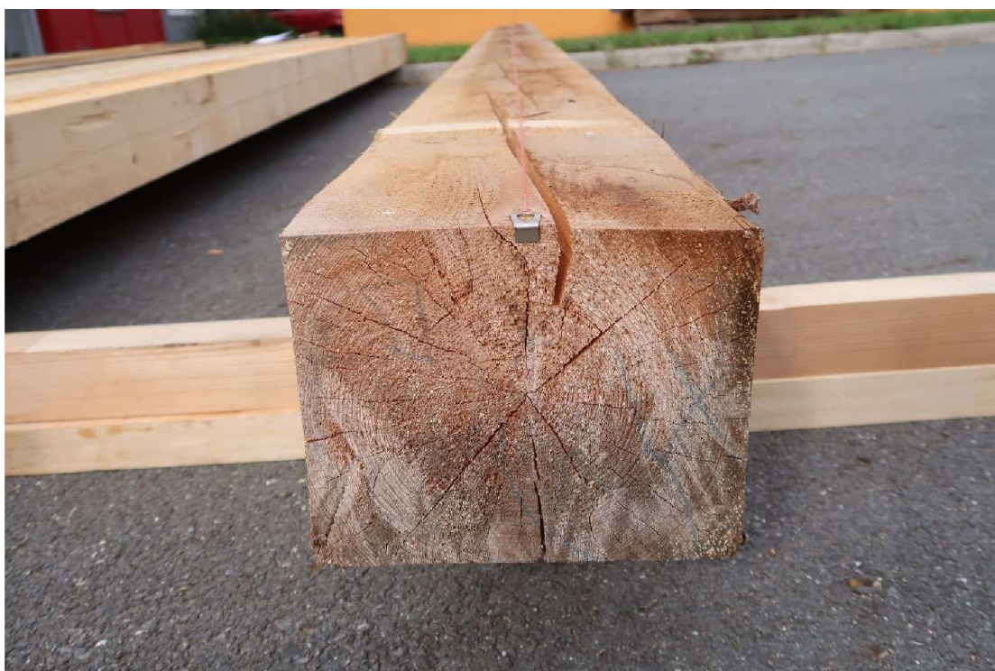
Obrázek 4.14 – přichycení lajnovací šňůry označující osu trámu
