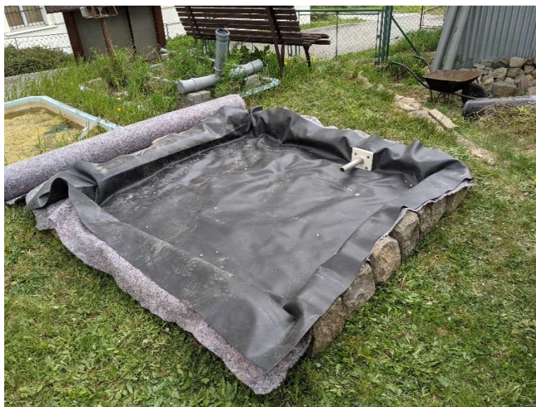
Obrázek 16 – Hydroizolační souvrství
