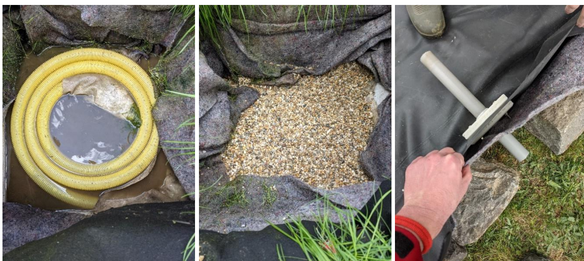
Obrázek 19 - Realizace drenážní vrstvy a prostupu hydroizolací
