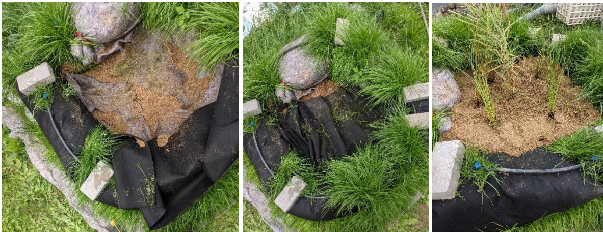
Obrázek 20 - realizace filtrační vrstvy a výsadba mokřadních rostlin
