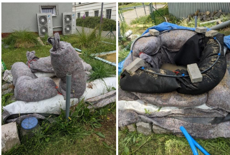
Obrázek 17 - Realizace stěn vertikálního filtru z pytlů plněných recyklátem.
