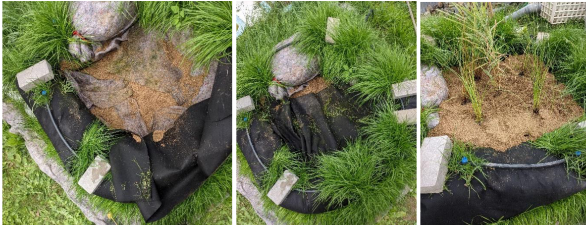
Obrázek 20 - realizace filtrační vrstvy a výsadba mokřadních rostlin
