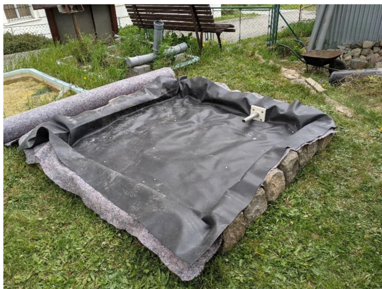
Obrázek 16 – Hydroizolační souvrství
