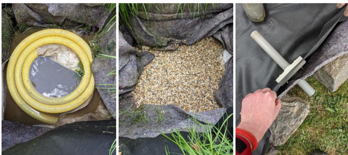
Obrázek 19 - Realizace drenážní vrstvy a prostupu hydroizolací
