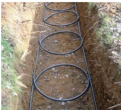
Obrázek 2.4:spirálový kolektor pro TČ země voda [51]
