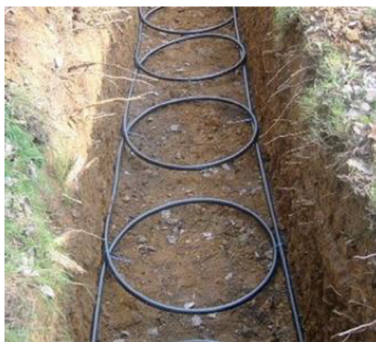
Obrázek 2.4: spirálový kolektor pro TČ země voda [51]
