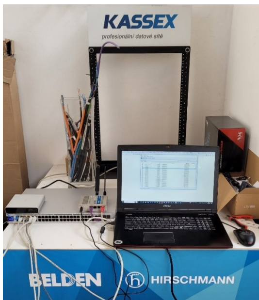
Obr. 4.6 Zkušební realizace v hale
