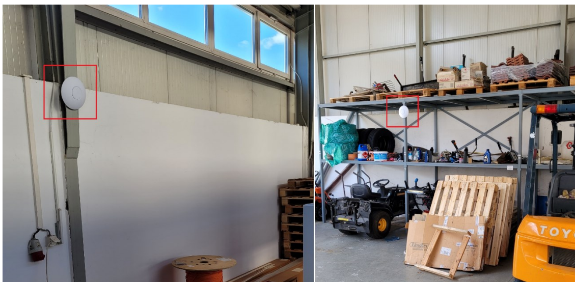
Obr. 4.12 Umístění AP, horizontální montáž
