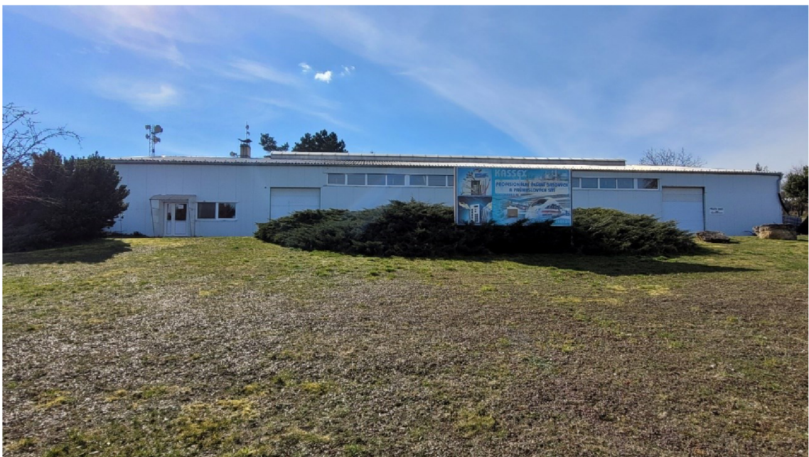
Obr. 3.1 Čelní pohled na halu firmy Kassex s.r.o.
