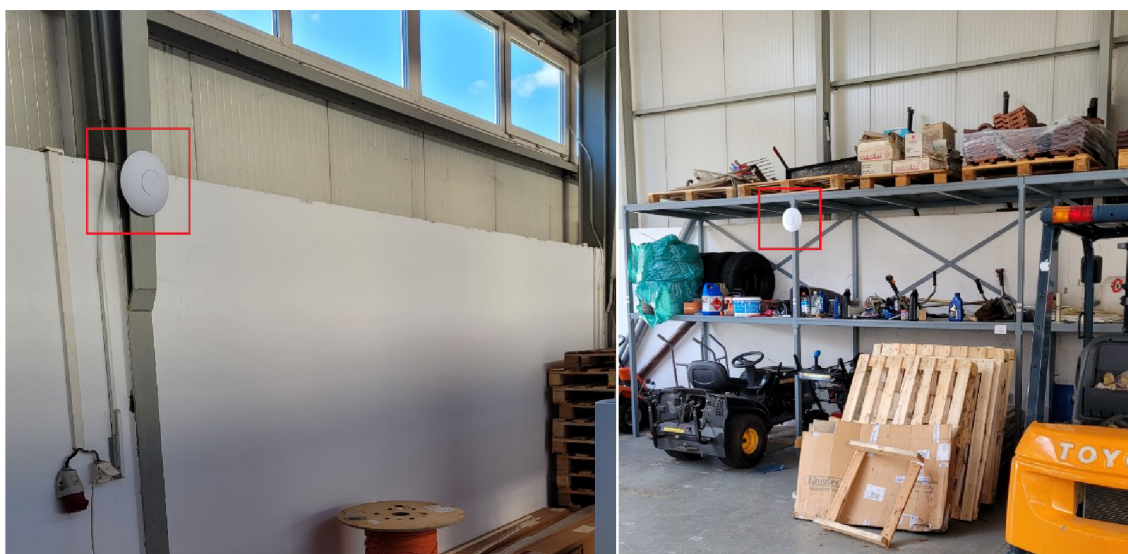
Obr. 4.12 Umístění AP, horizontální montáž
