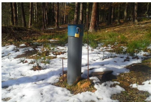
Obrázek 7.3: Jímací vrt v lokalitě Sychrov (Vacek, 2016)
