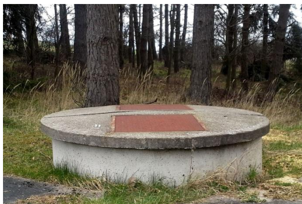
Obrázek 7.5: Betonový poklop jímacího vrtu v prameništi Svatá Anna (Vacek, 2016)
