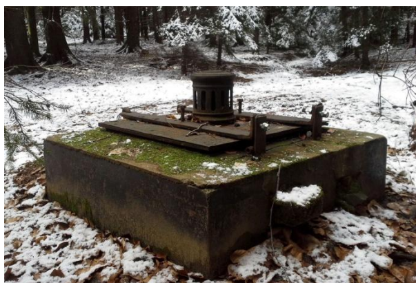
Obrázek 7.4: Poklop pramenné jímky v lokalitě Baba (Vacek, 2016)
