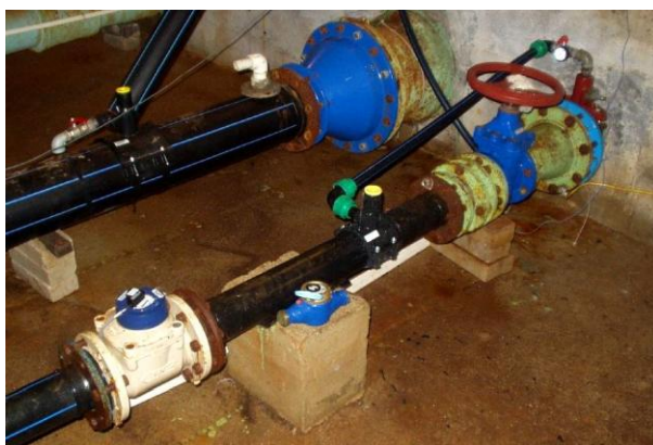
Obrázek 7.10: Vodoměr převzaté vody z přivaděče z Příbrami ve vodojemu Svatá Anna (Kunický, 2010)
