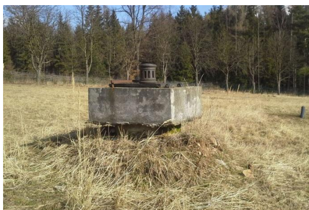
Obrázek 7.9: Pramenní jímka v prameništi pro sanatorium (Vacek, 2016)
