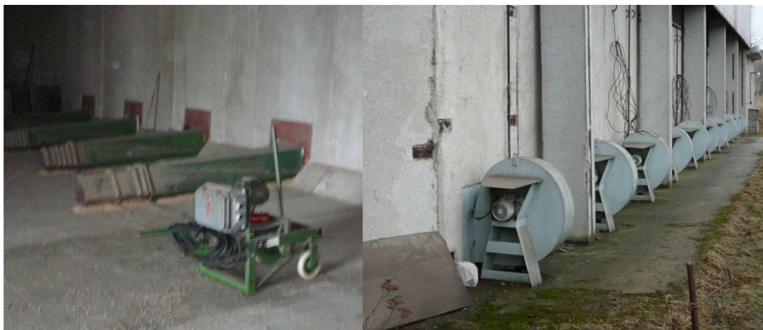
Obrázek 10 - Provdzušňovací ventilátory podlahového skladu (zdroj dat: vlastní výzkum)
