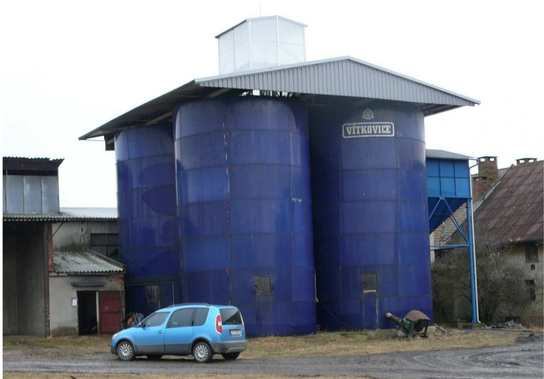
Obrázek 8 - Věžový sklad (zdroj dat: vlastní výzkum)
