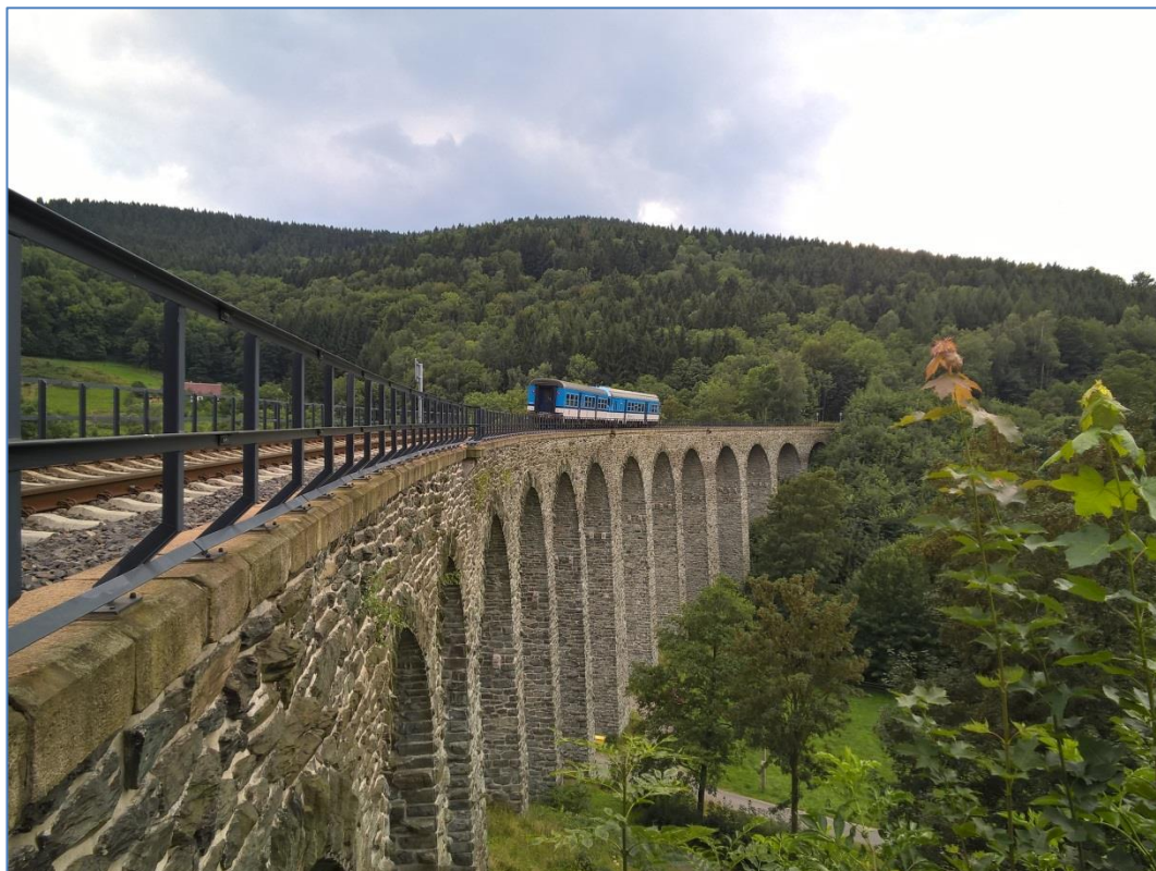
Obr. 13 – Terénní průzkum / Novinský železniční viadukt
