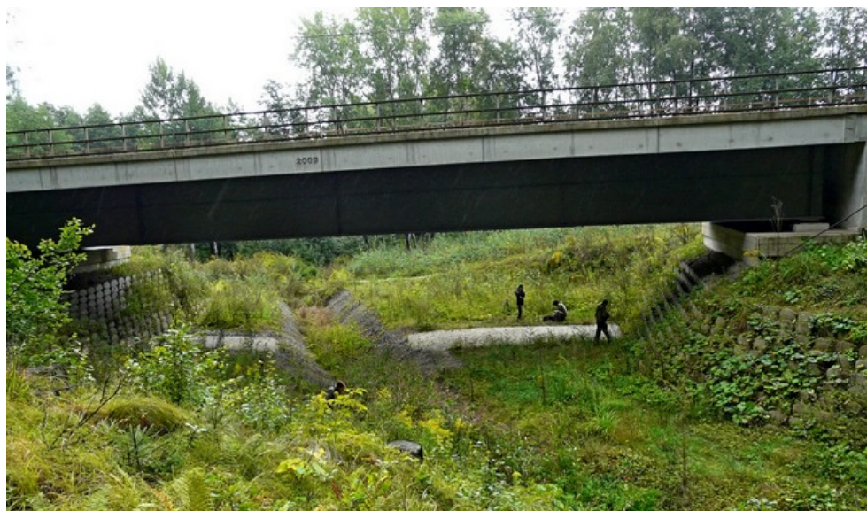
Obrázek č. 9 Most na komunikaci
