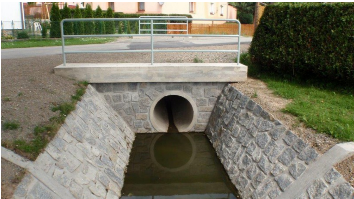
Obrázek č. 6 Trubní propustek
