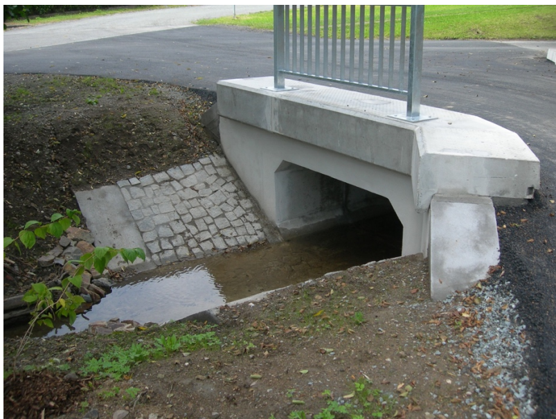
Obrázek č. 7 Rámový propustek
