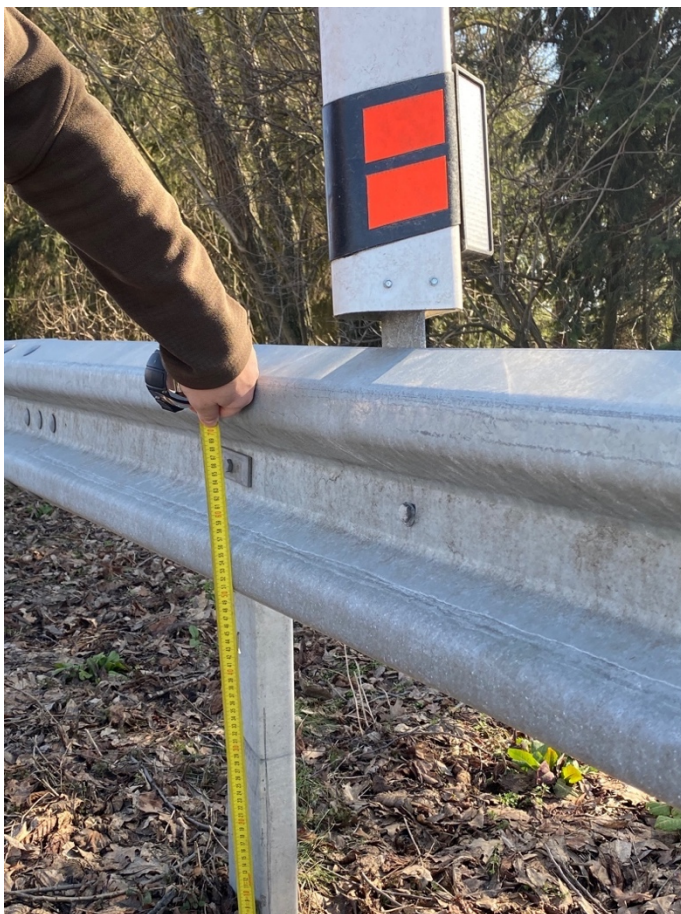
Obrázek č. 24 Výška svodidel
