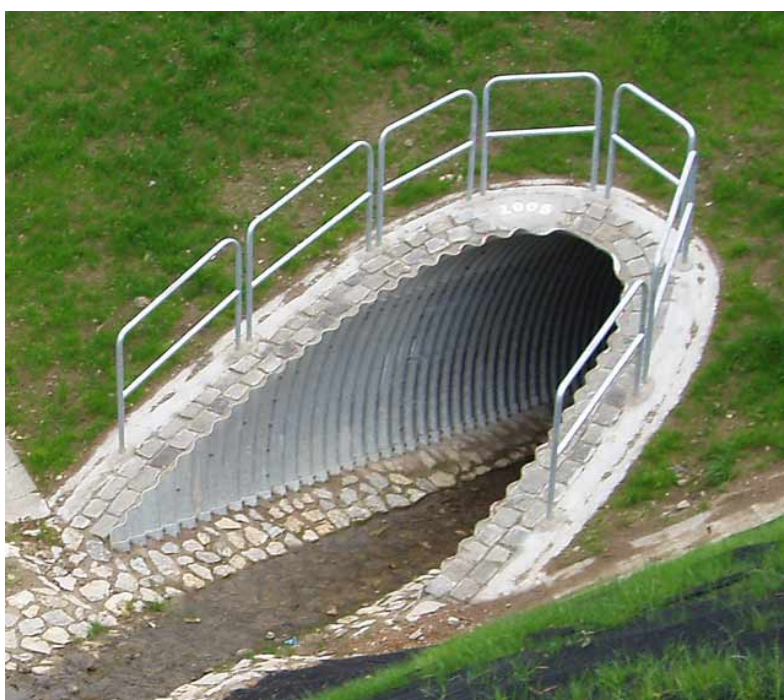
Obrázek č. 8 Tlamový propustek
