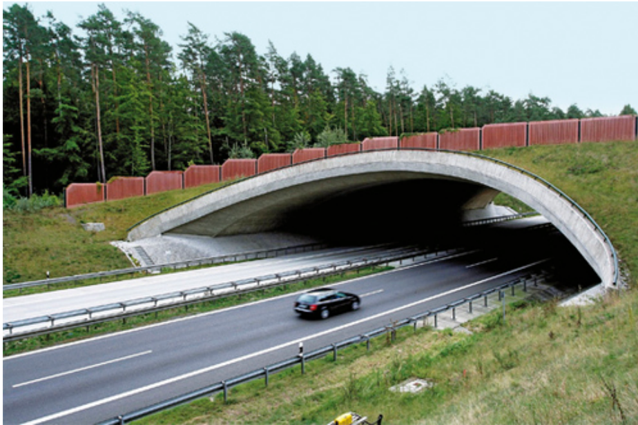
Obrázek č. 10 Most přes komunikaci
