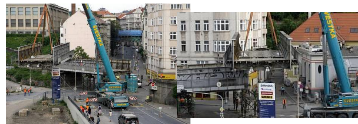
Obr. 56, 57: Demontace mostu malá Hrabovka, rok 2009, na fotce č. 55 lze v pozadí vidět rekonstrukci mostu Velká Hrabovka, který na místě stojí dodnes
