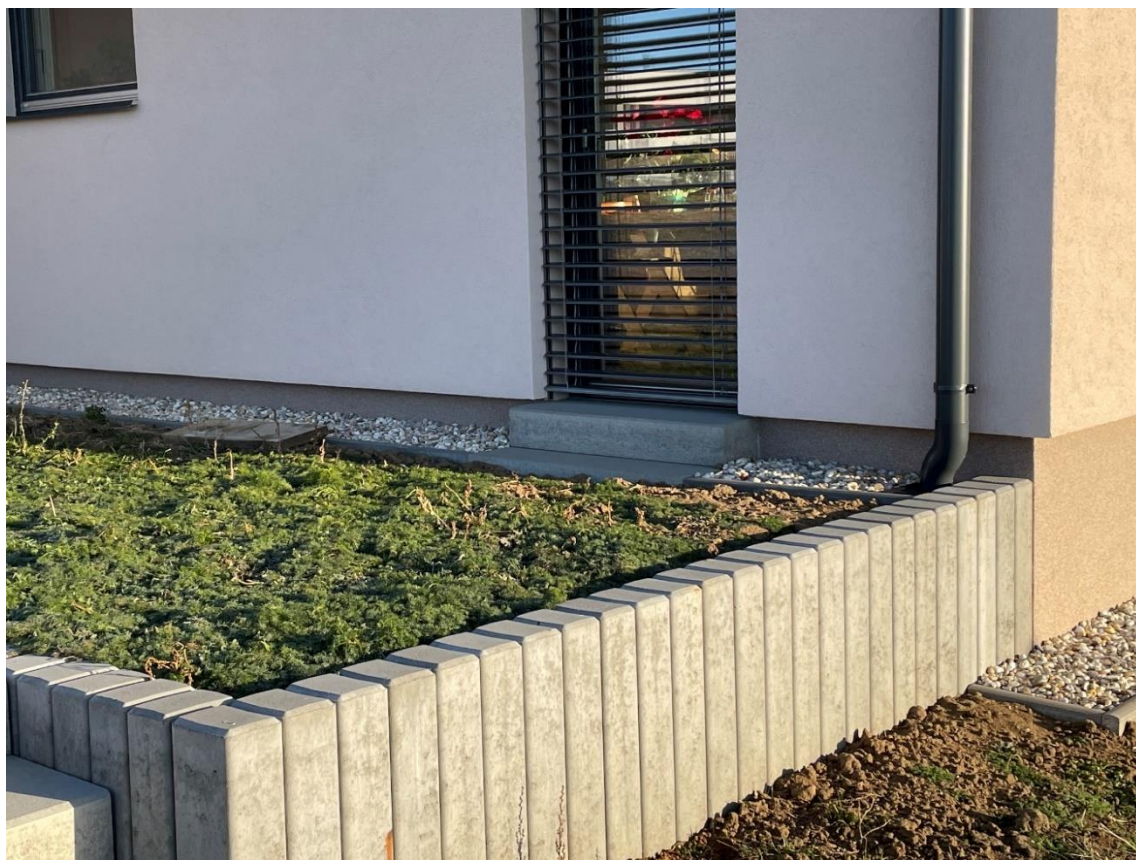
Obr. 26: Fotka základového soklu s dveřmi na terasu
