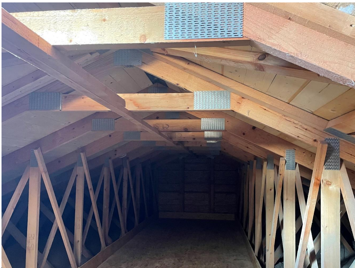
Obr. 37: Fotka střešní konstrukce
