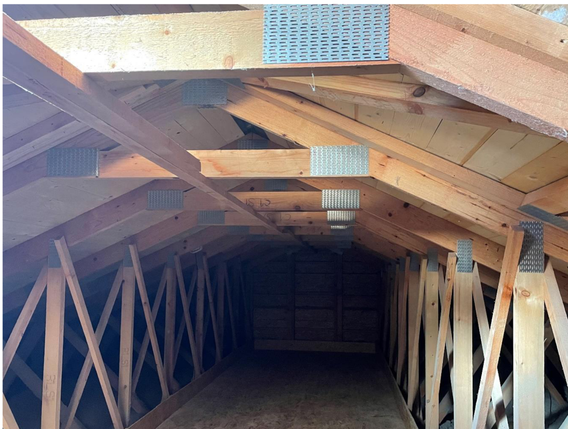
Obr. 37: Fotka střešní konstrukce
