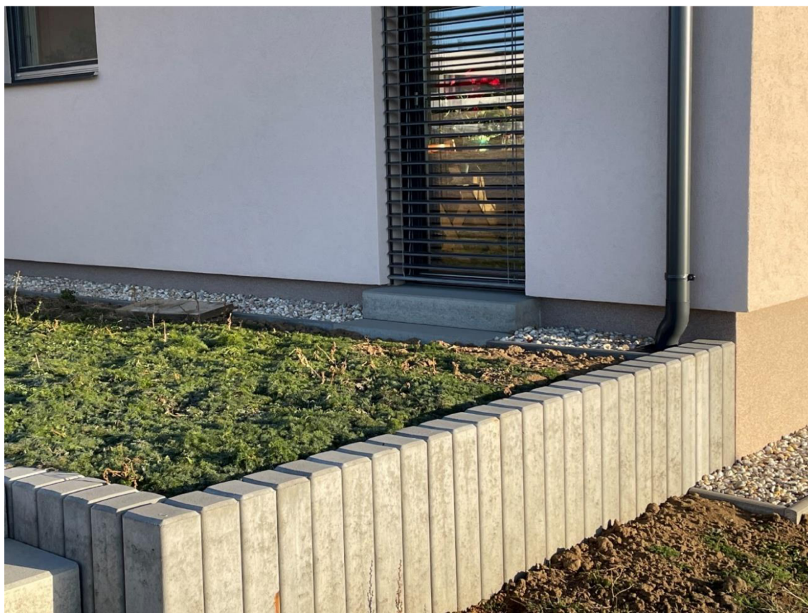
Obr. 26: Fotka základového soklu s dveřmi na terasu
