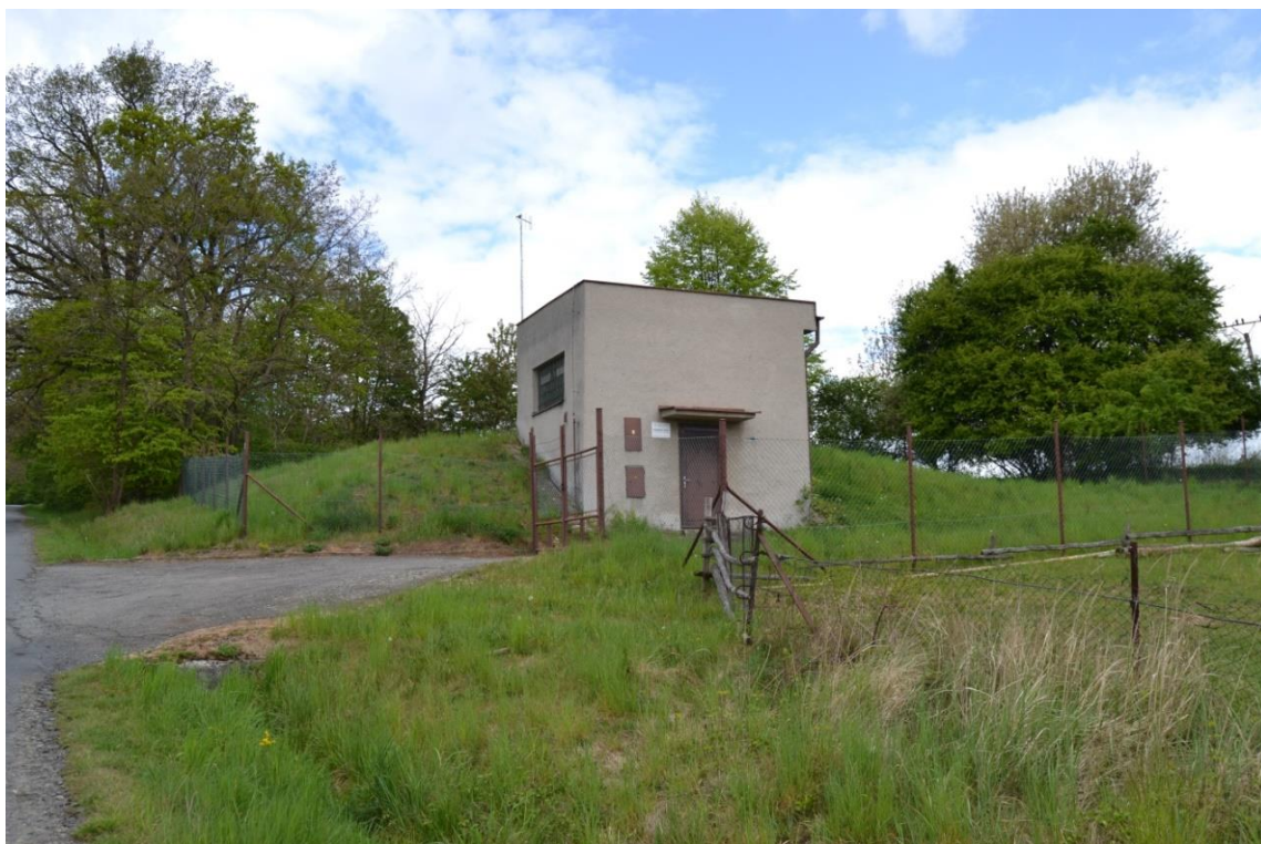
Obr. 7: Vodozvedací budova Teplice nad Bečvou (P. Trchalíková, duben 2020)
