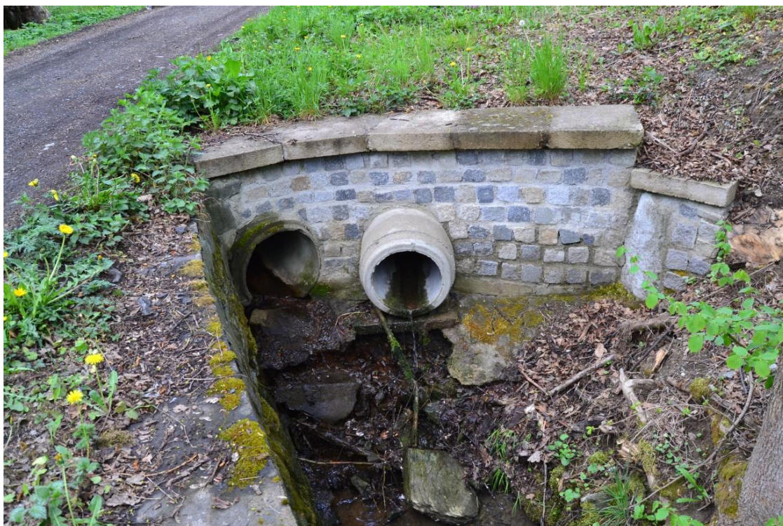
Obr. 13: Propustek bezejmenného pravostranného přítoku Krkavce (P. Trchalíková, březen 2020)
