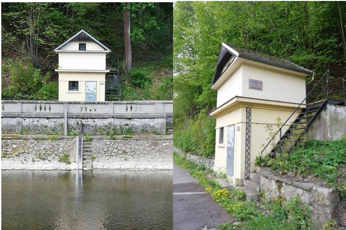
Obr. 6: Vodoměrná stanice Teplice nad Bečvou (P. Trchalíková, duben 2020)
