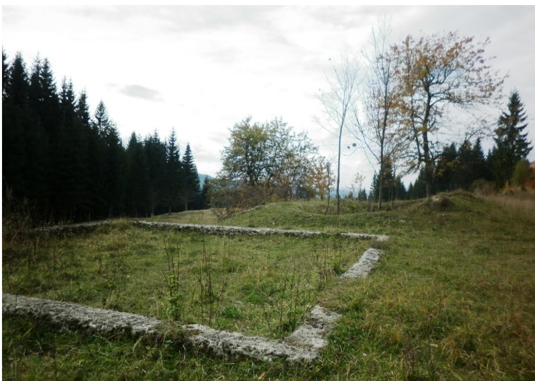
Fotografia č. 22: Základy harvelského domu ako jediná pamiatka bývalej stavby (november 2013). 196
