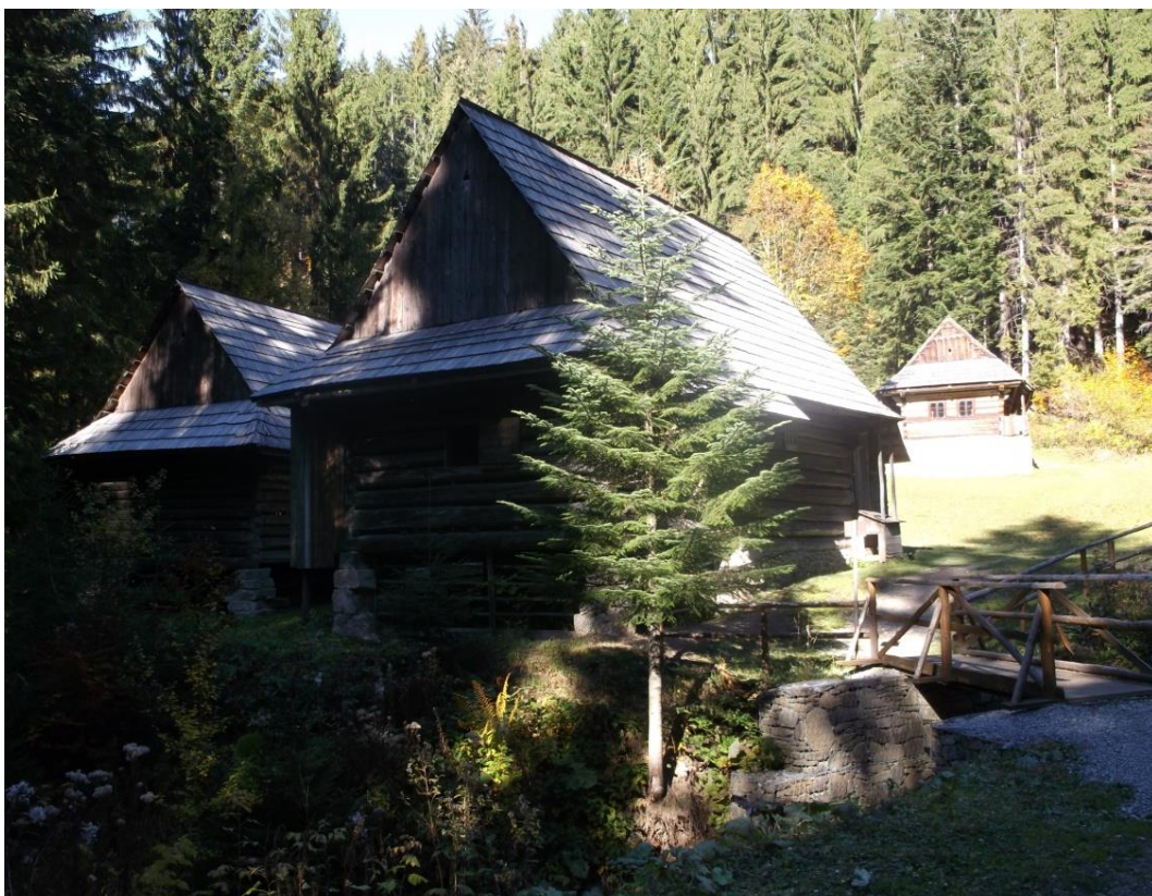
Fotografia č. 27: Hospodárske stavby od Hruškuliaka umiestnené v Múzeu kysuckej dediny vo Vychylovke (september 2013). 201
