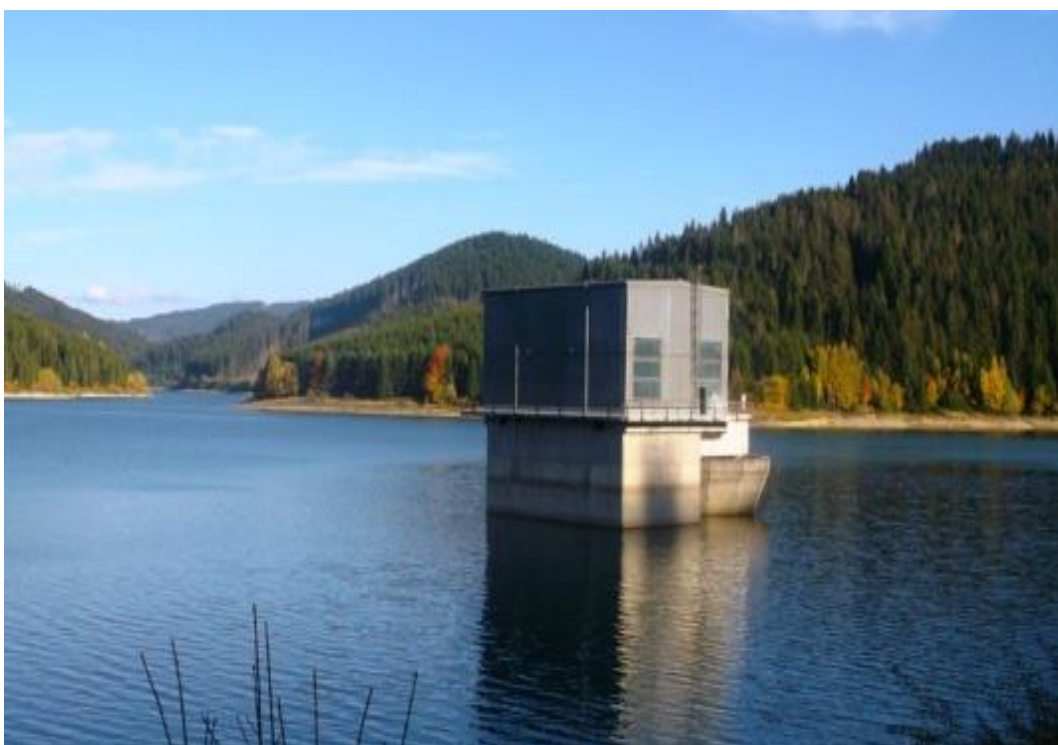
Fotografia č. 24: Súčasný pohľad na vodnú nádrž Nová Bystrica. Pohľad od Novej Bystrice (november 2013). 198
