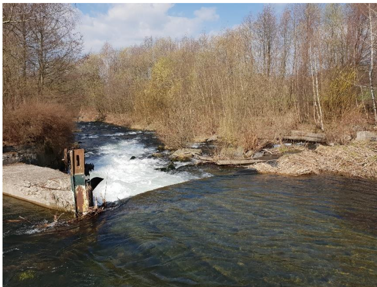
Obr. 17 Balvanitý jez na toku
