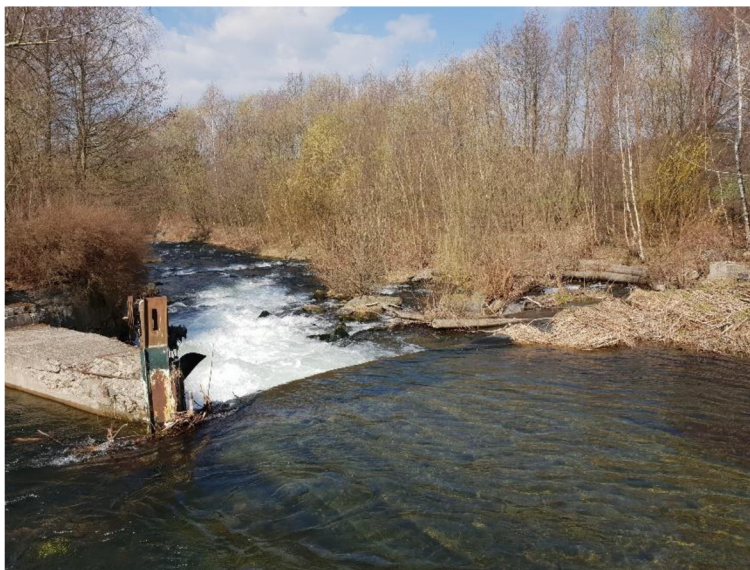
Obr. 17 Balvanitý jez na toku
