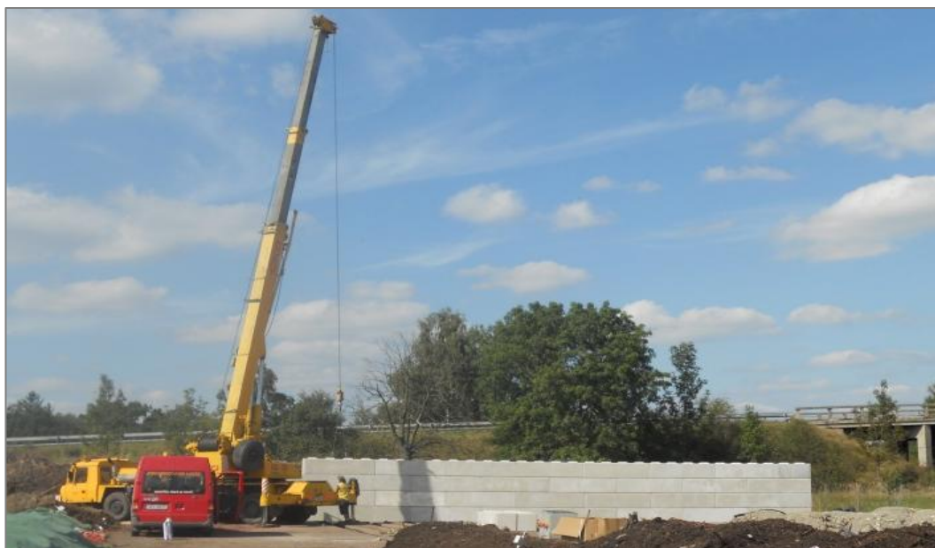
Foto č. 12: Průběh výstavby nové technologie na CMC Náměšť a. s. (Doležalová, září 2011)
