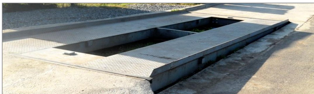
Foto č. 6: Silniční váha (Doležalová 2011)
