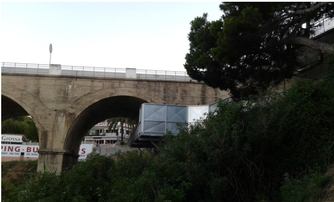
Obr. 20: Detailní záběr nevhodně řešeného podchodu u přístupové cesty na pláž v Calelle, 2015. Foto: Kamila Malínská
