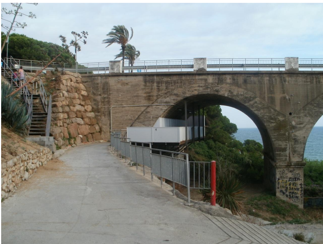
Obr. 21: Podchod v destinaci Calella, ve kterém je pravidelně smýváno graffiti vytvářené na stěnách podchodu, 2015. Foto: Kamila Malínská
