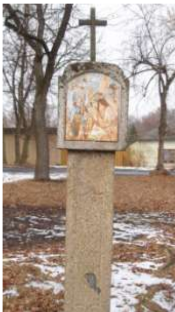
Obrázek 10 Vybledlá a oprýskaná barva na sloupku křížové cesty
