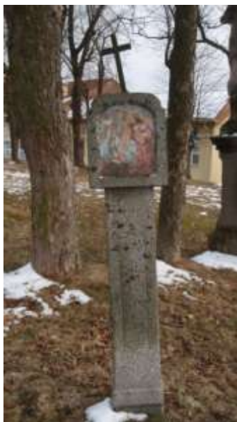
Obrázek 7 Vychýlení žulového sloupku z vlastní osy
