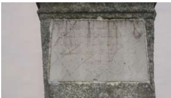
Obrázek 9 Popraskaná kamenná deska s nečitelným nápisem
