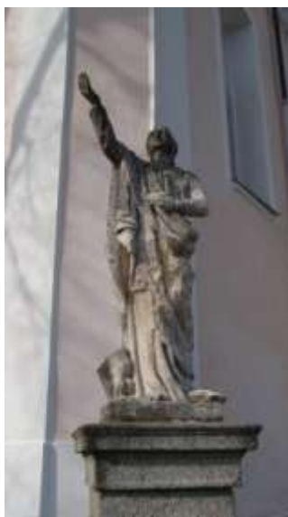
Obrázek 8 Chybějící část sochy a postupné odlamování kamene
