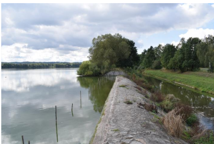
Obr. 9: Kapacitní koryto u Buzic a bezpečnostní přeliv Buzického rybníka (vlastní fotografie)
