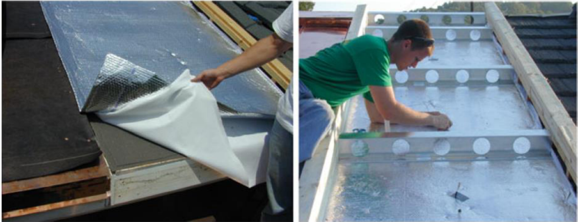
Obr. 6: Instalace PCM do střešní konstrukce (Košny, 2015)
