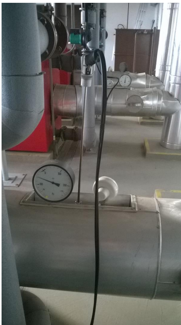
Příloha č. 8 – měřící otvor se sondou (zdroj: Ladislav Grössl)
