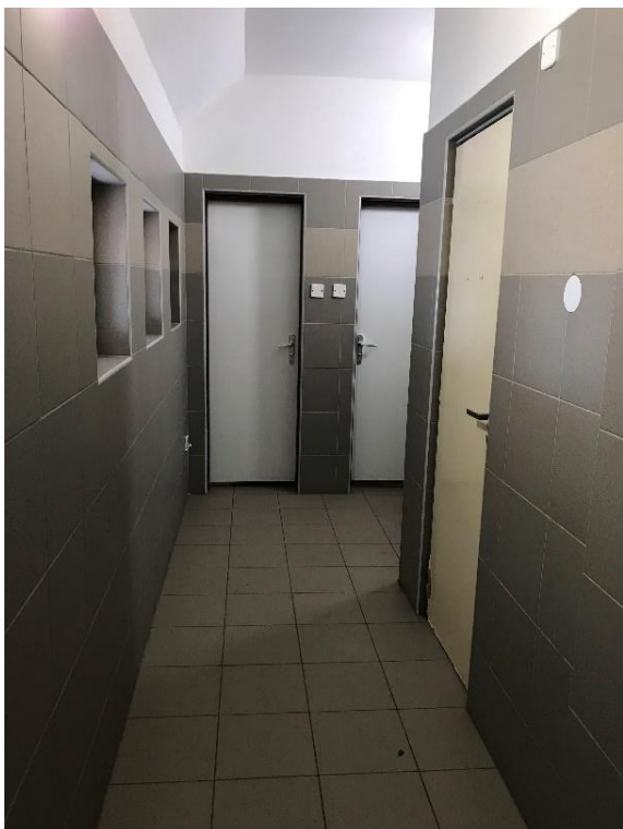
Obrázek 17. Vstupní chodba k WC u parkoviště.
