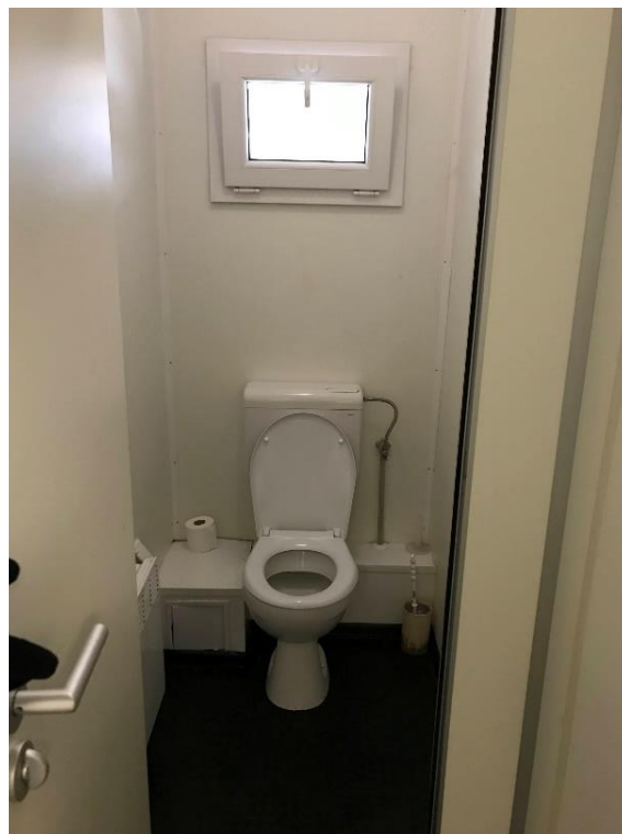
Obrázek 22. WC u trasy v šatnách (v levé části areálu).
