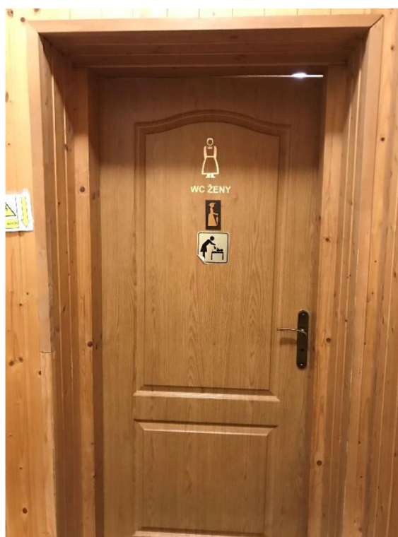
Obrázek 32. Vchod k WC.
