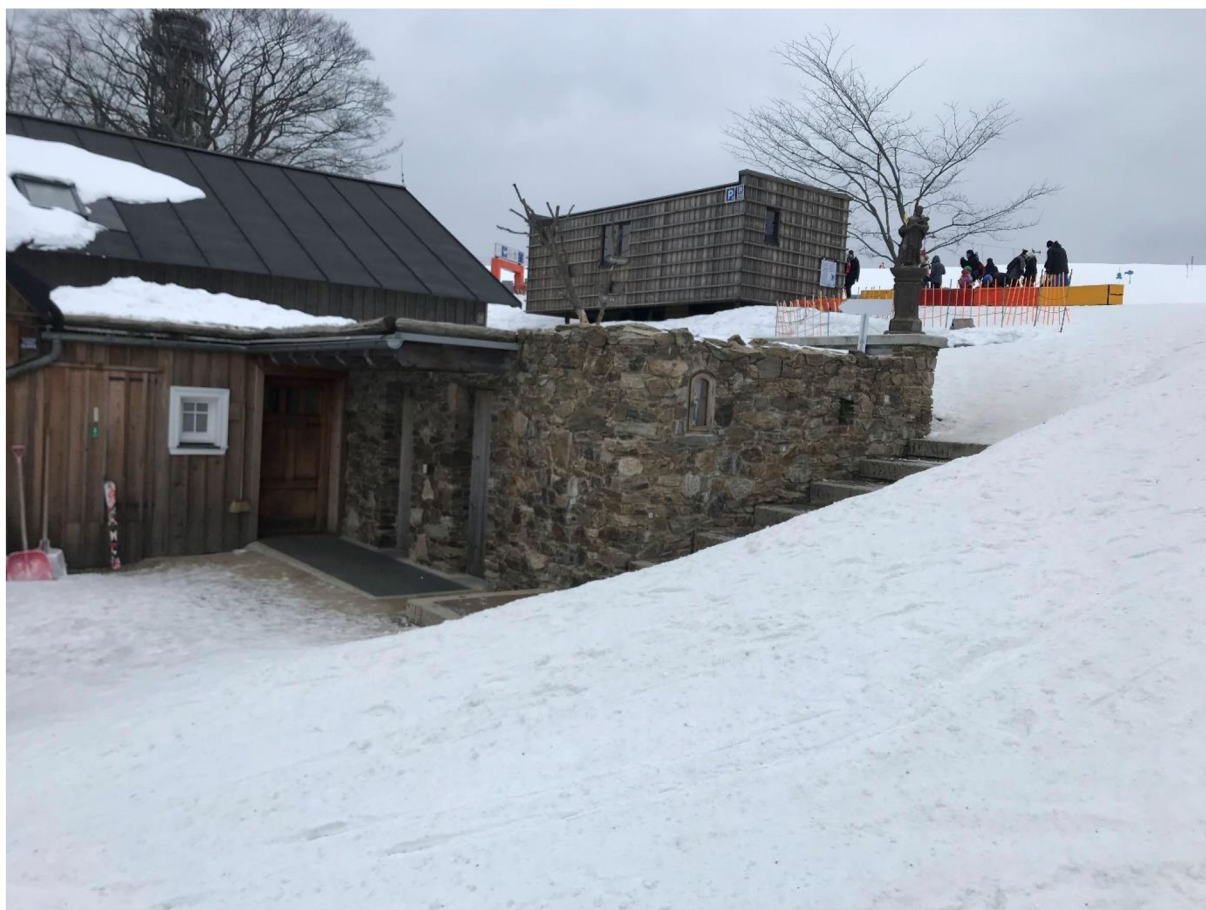
Obrázek 26. Přístup do restaurace (WC).
