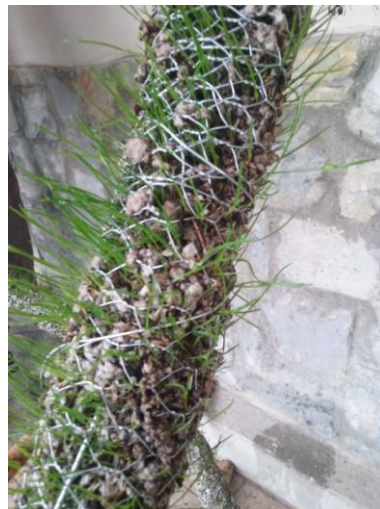
Obr.č. 58 a č.59 Aplikace papermasche s hlínou a semeny do konstrukce
