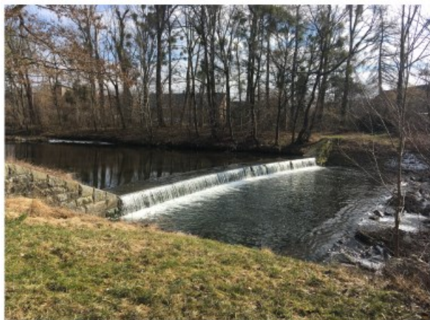
Obr. 8a: Spádový stupeň na Lubině (ř. km 18,51) (© J. Polášek, únor 2022)
