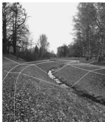
Obr. 5b: Ochranná hráz na Kopřivničce (© J. Polášek, říjen 2021; upraveno)
