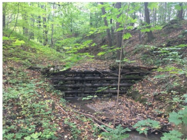
Obr. 9b: Srubová přehrážka na bezejmenném LP Kopřivničky (© J. Polášek, září 2021)
