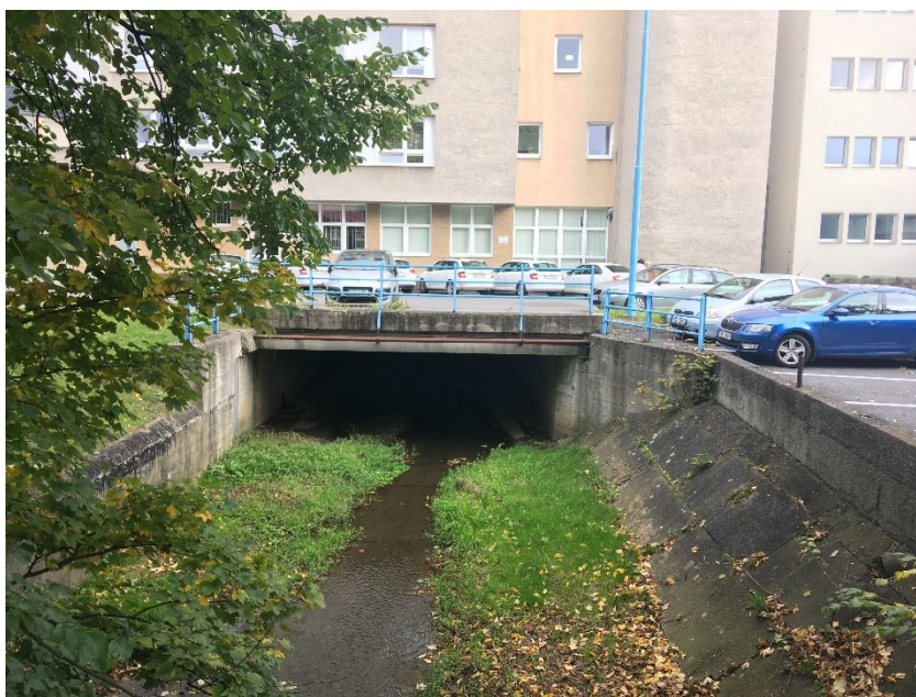
Obr. 16: Vyústění zaklenutého úseku Grasmanky v ř. km 0,88 (© J. Polášek, říjen 2021)
