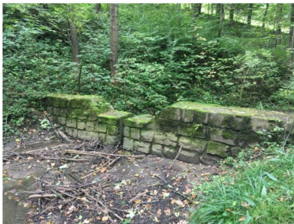
Obr. 9a: Kamenná přehrážka v pramenné oblasti Kopřivničky (© J. Polášek, září 2021)
