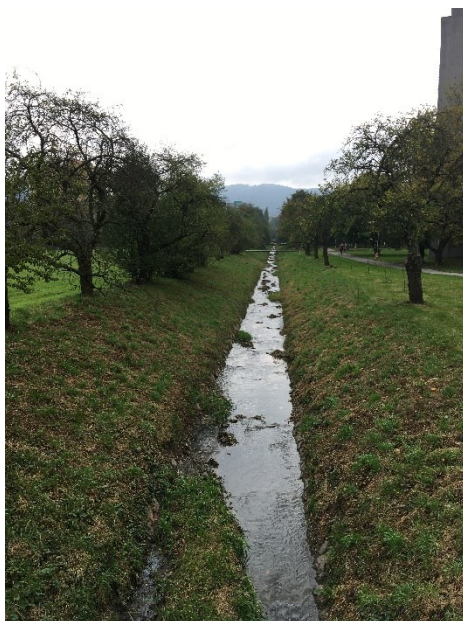
Obr. 14: Napřímené a zahloubené koryto Kopřivničky (© J. Polášek, říjen 2021)
