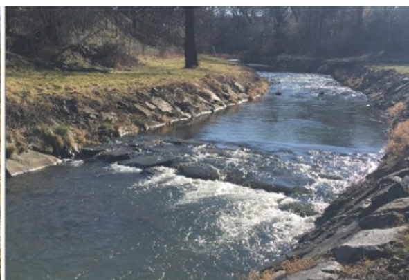
Obr. 12b: Kaskáda skluzů na Jičínce (ř. km 10,10–10,20) (© J. Polášek, únor 2022)
