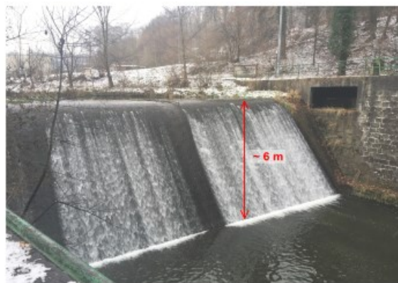
Obr. 7b: Jez na Jičínce v místní části Žilina (© J. Polášek, listopad 2021)
