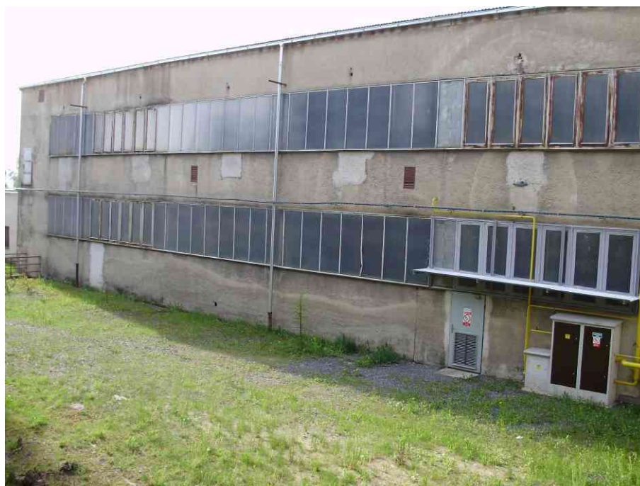
Obr. č. 7 – Objekt zámečnických dílen - pohled na delší stranu budovy.
