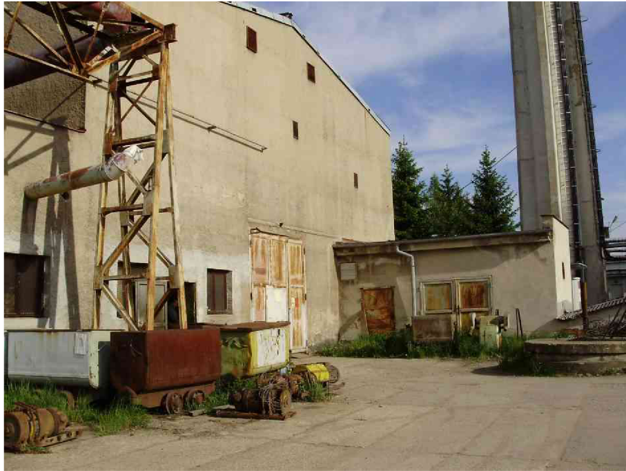
Obr. č. 6 – Objekt zámečnických dílen – vjezd do hlavní dílny.
