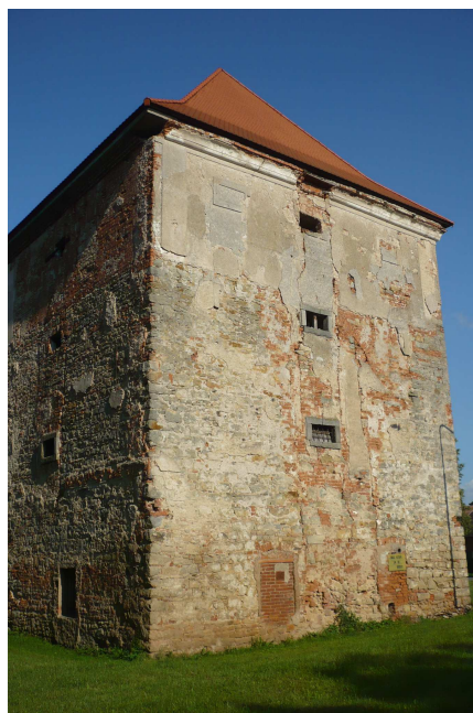
Tvrz v Dohalicích, roh severního a západního průčelí.
