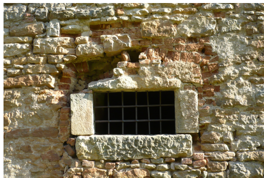
Tvrz v Dohalicích, severní průčelí, detail okna.
