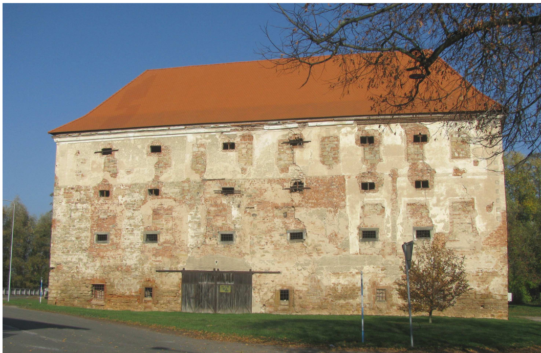
Tvrz v Dohalicích, jižní průčelí.
