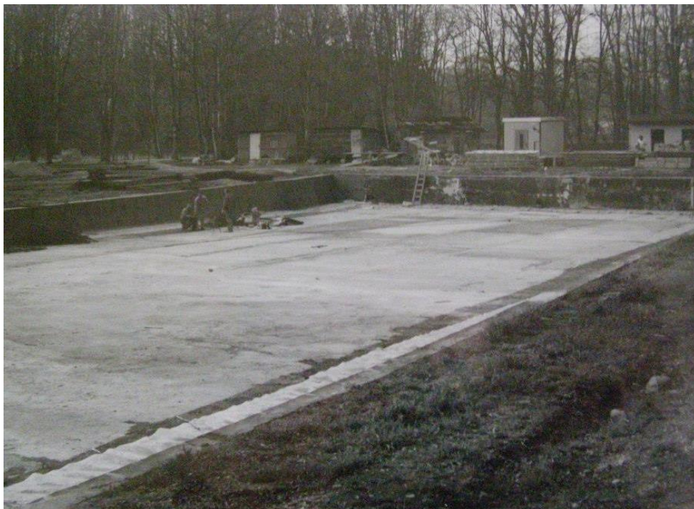
Obrázek 11 – Výstavba koupaliště v parku.
