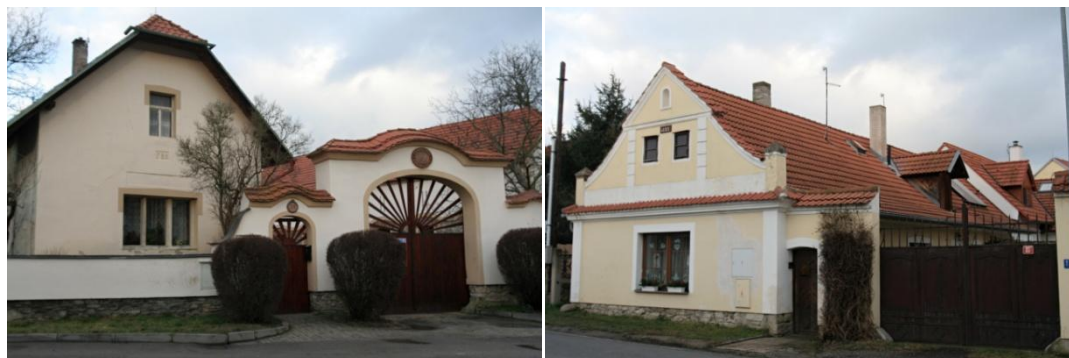
Obr. č. 8 – 9 - Původní budovy, které byly zmodernizovány
