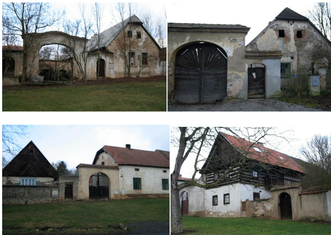
Obr. č. 18 – 19 - Ukázka dochovaných staveb v obci Mořinka, které jsou však ve zchátralém stavu
