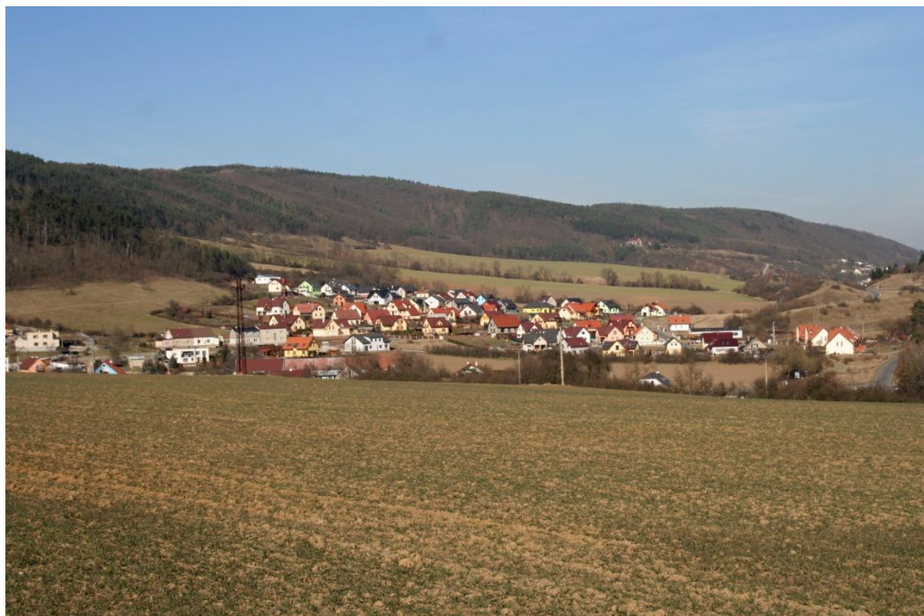
Obr. č. 61 - Dokončená 2. etapa výstavby v obci Zahořany
