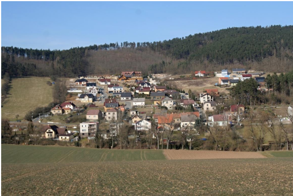
Obr. č. 58 - Dokončená 1. etapa výstavby v obci Zahořany
