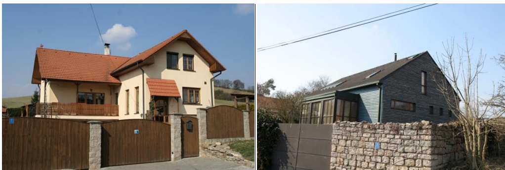
Obr. č. 43 – 44 - Ukázka nové výstavby v obci
