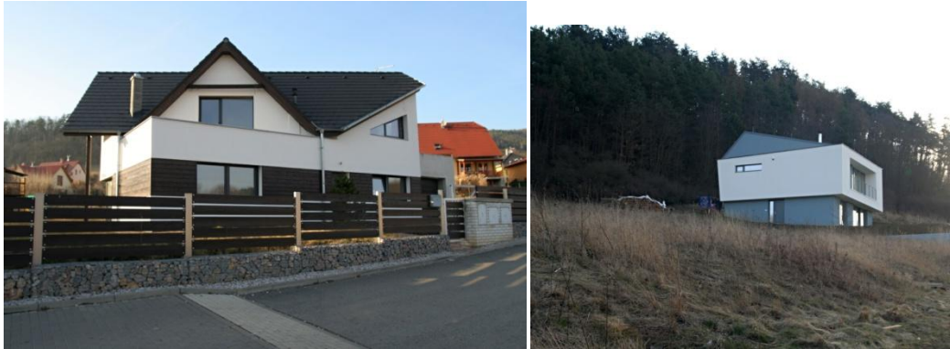
Obr. č. 62 – 63 - Ukázka novostaveb v obci Zahořany
