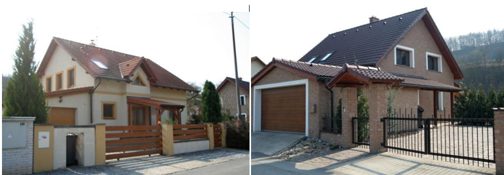
Obr. č. 34 – 35 - Ukázka novostaveb v obci Karlštejn
