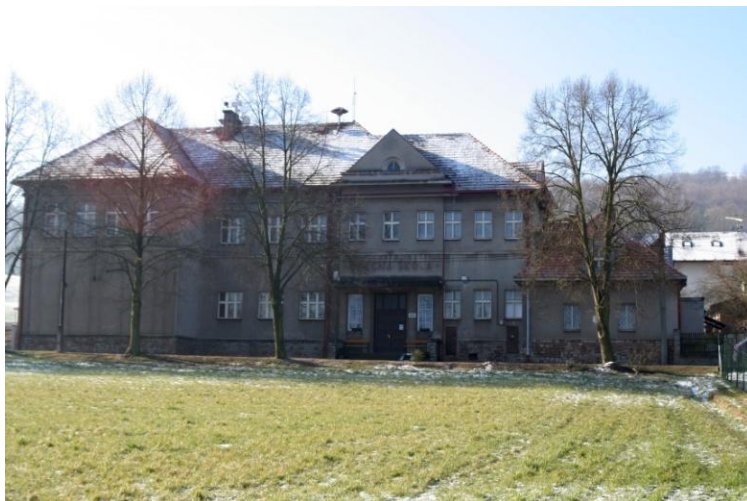
Obr. č. 15 – Bývalá Základní škola v obci Koněprusy
