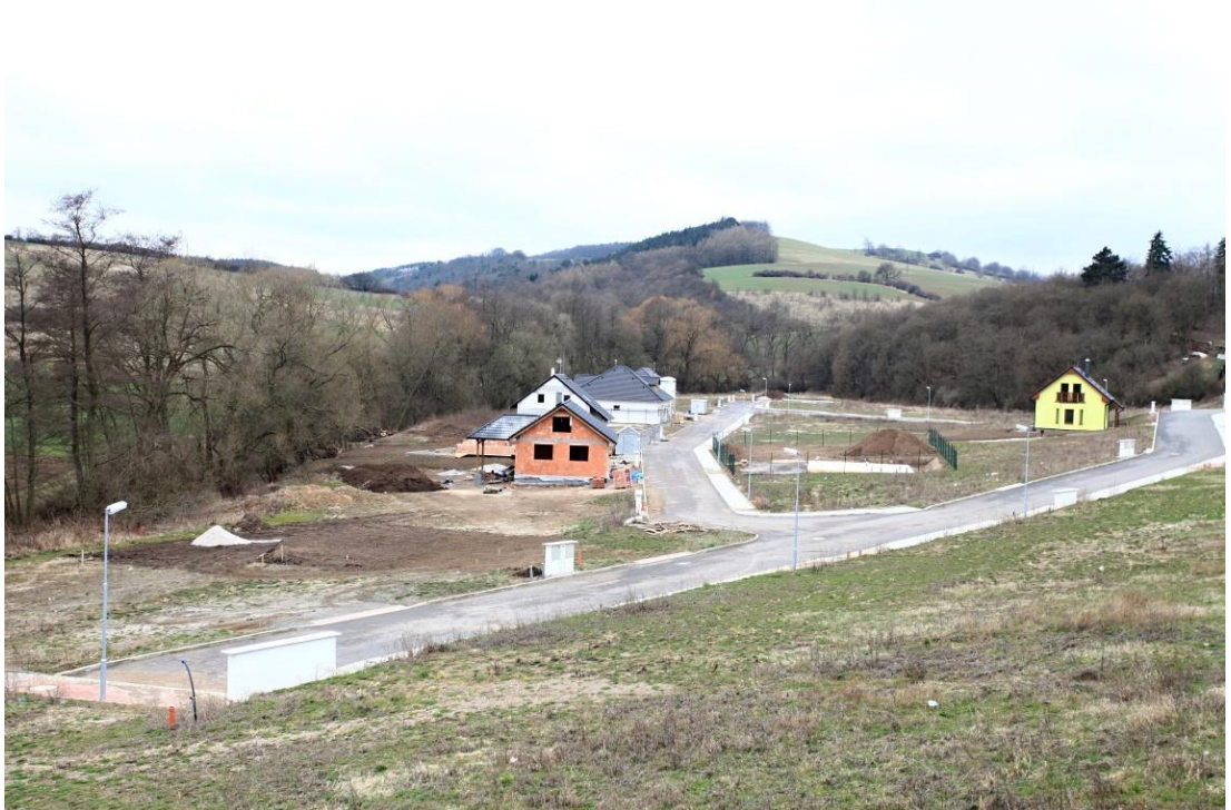
Obr. č. 64 – Započatá 3. etapa výstavby v obci Zahořany
