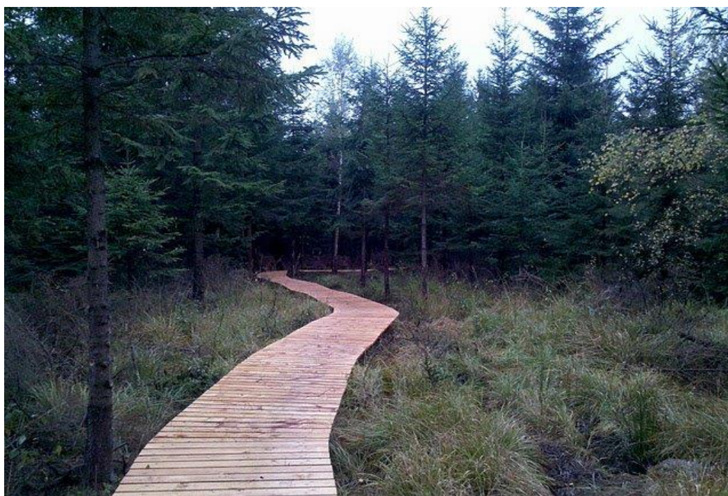
Obrázek 9. Zpevnění podmáčených míst, Kvasnička, T. & Slavík, P. (2011)
