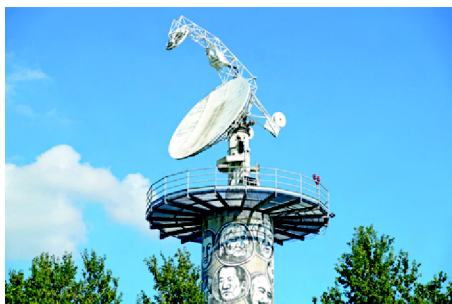
Obrázek 3.2: Radarová věž sloužící k monitorování všeobecného provozu kolem letišť. [3]
